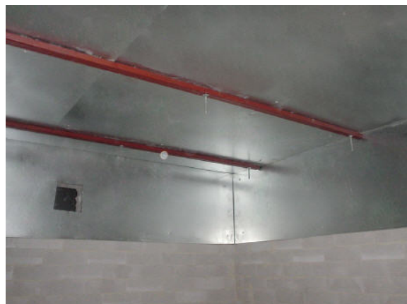
MuFerro™ 6800 plafond hoed-constructie
